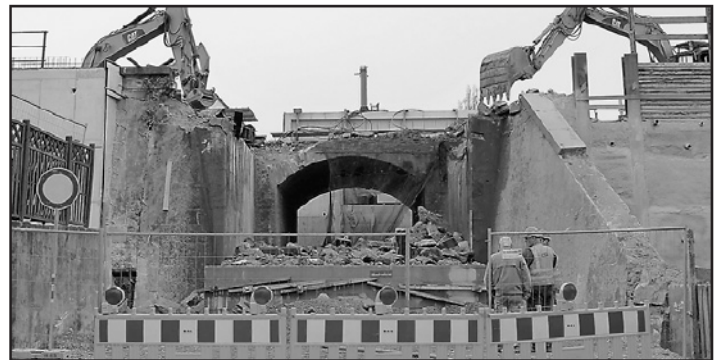
Die alte, aus dem Jahr 1857 bestehende Brücke wurde gleich von zwei Seiten abgerissen.
