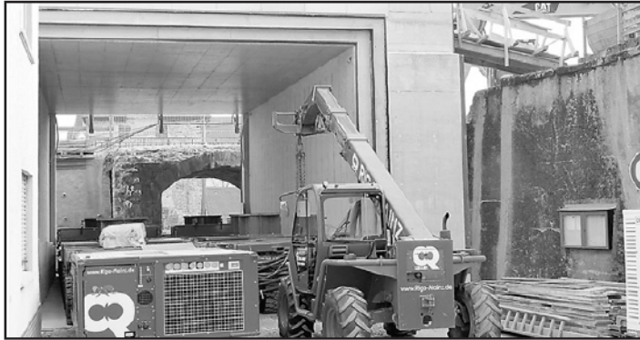
Die neue Eisenbahnüberführung in Hattenheim wurde auf einem 48-Doppelachser eingeschoben
