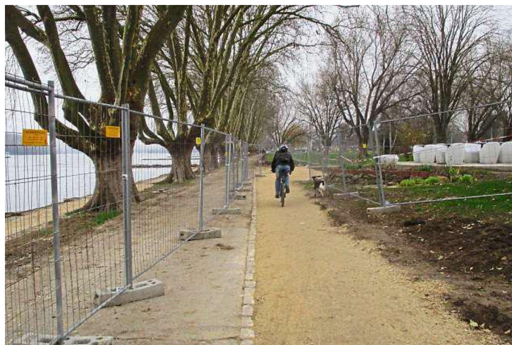
Bis der neue Rad- und Gehweg am Rhein fertig ist, müssen Radler in den nächsten Monaten noch einige Umleitungen in Kauf nehmen. Fotos: Stadt Geisenheim
