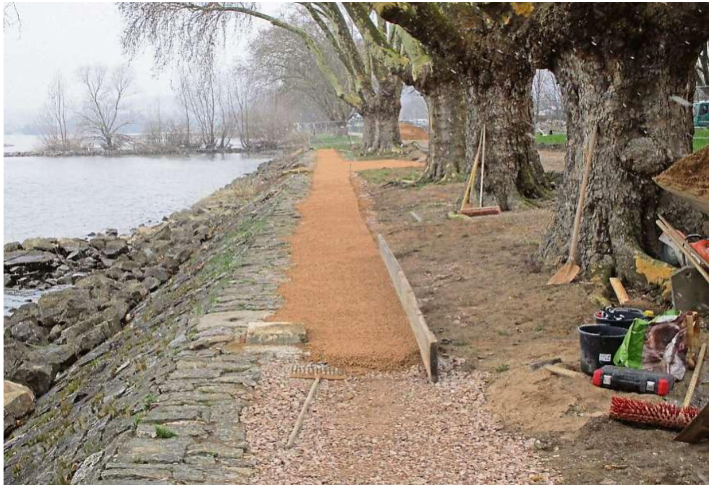
Die Sanierung der Wege am Geisenheimer Rheinufer ist fast beendet.
